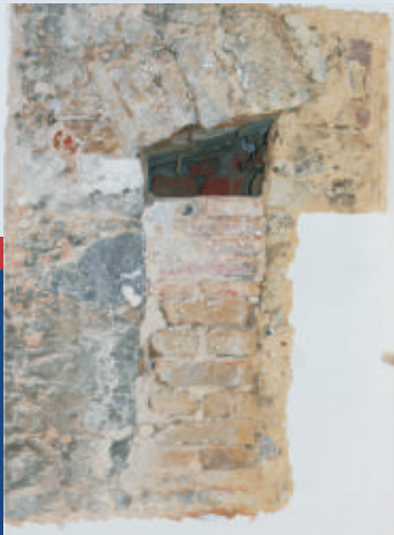
Neufund: Fenster des Vorgängerbaues (2009)
