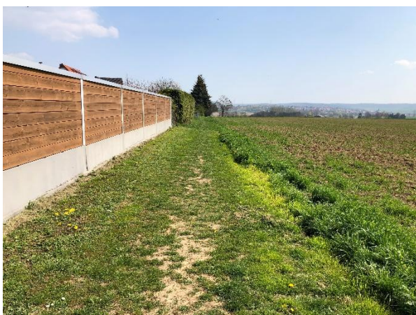
Abb. 21: Wiesenweg / Schutzstreifen Gasleitung entlang der nördlichen Grenze des Plangebietes
